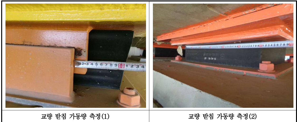
【사진 31.3.15】 교량받침 이동량 측정
