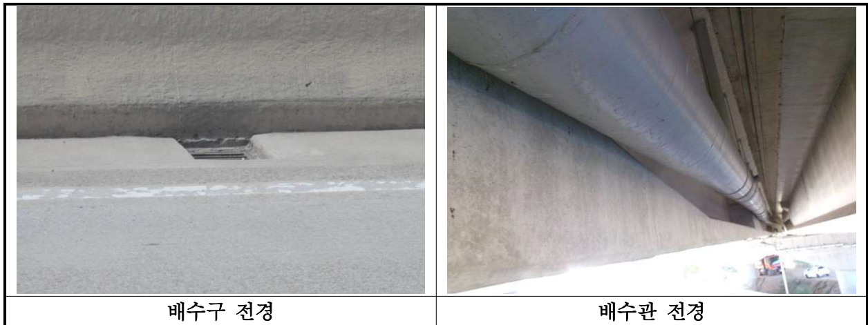
【사진 31.3.21】 배수시설 전경
