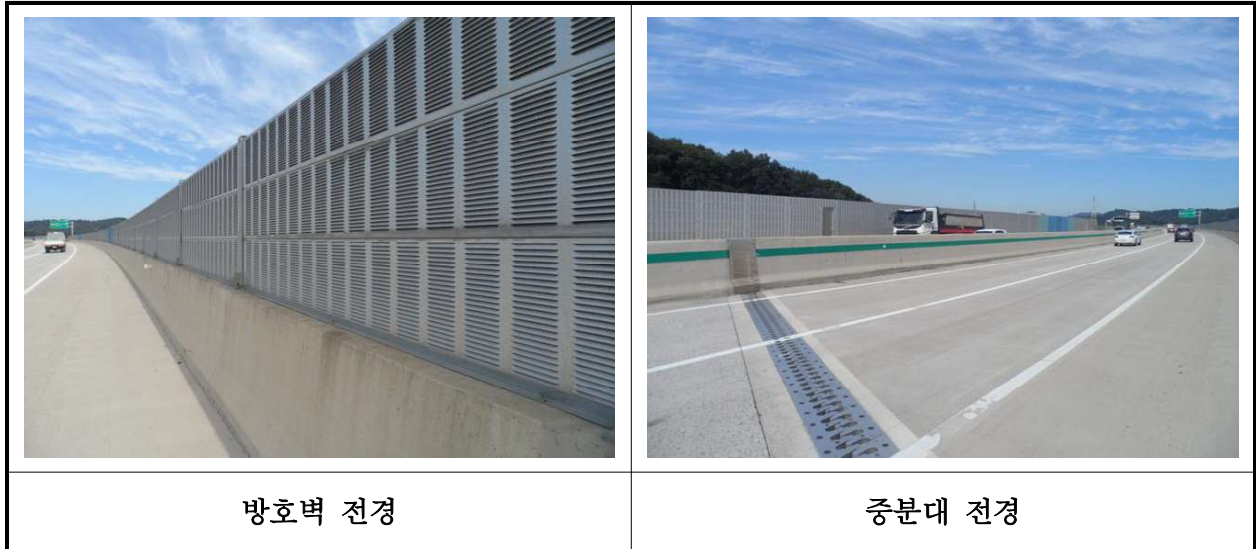
【사진 31.3.23】 방호벽 및 중앙분리대 전경
