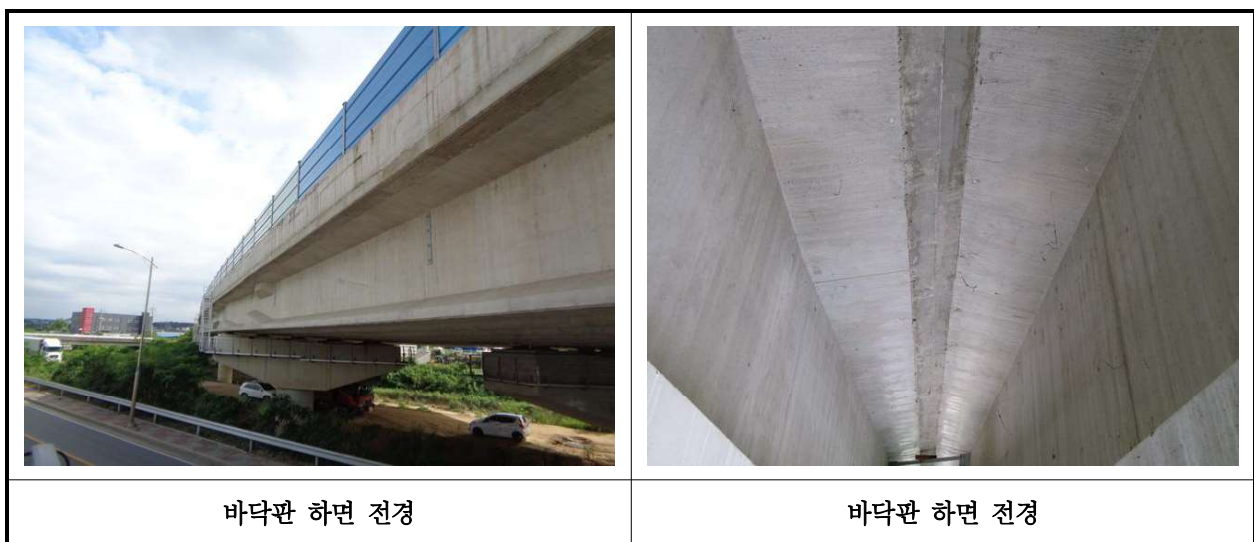
【사진 32.3.2】 바닥판하면 전경
