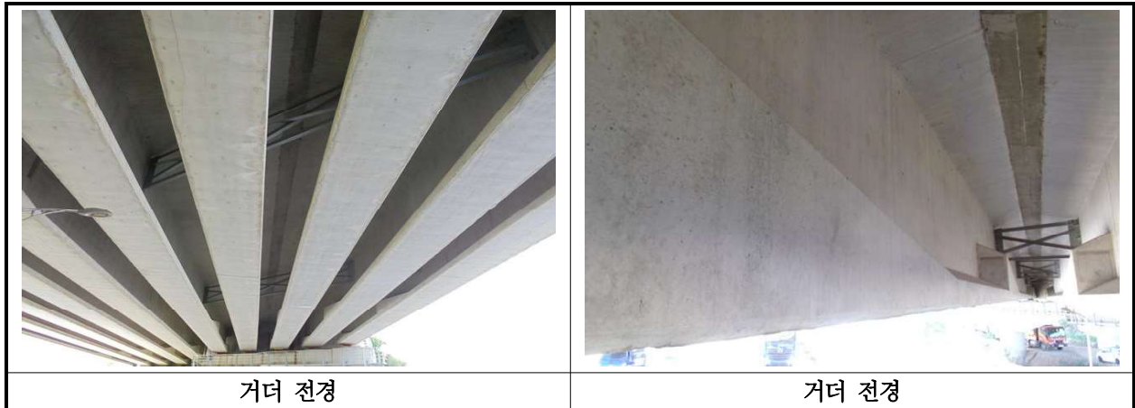
【사진 32.3.4】 거더 전경
