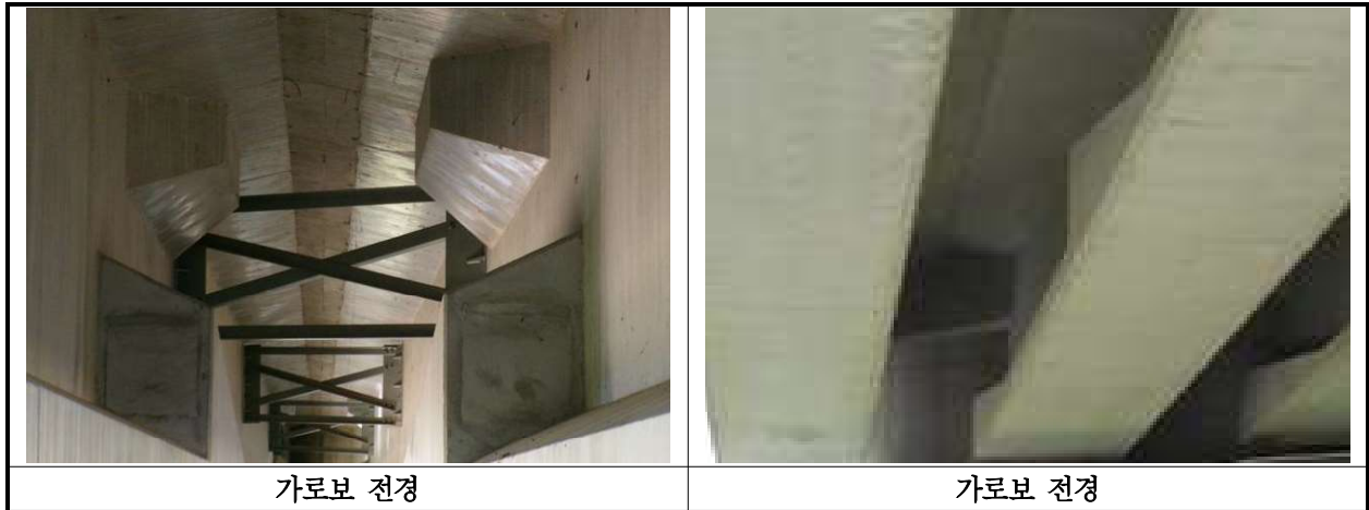
【사진 32.3.6】 가로보 전경
