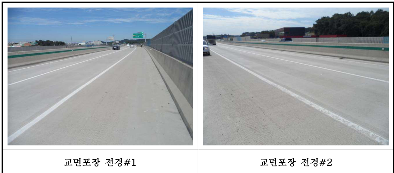
【사진 31.3.19】 교면포장 전경
