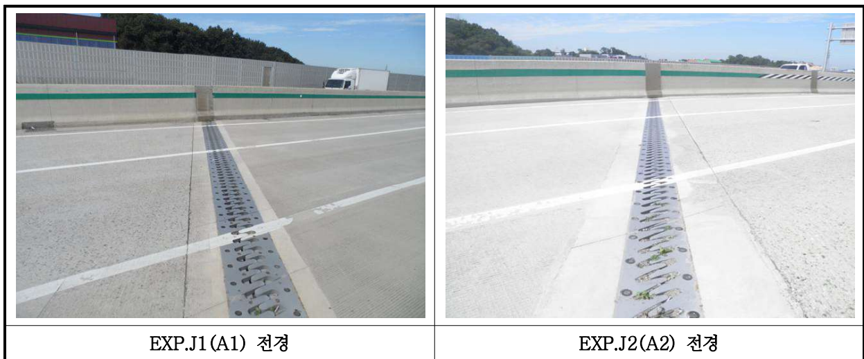
【사진 31.3.16】 신축이음장치 전경
