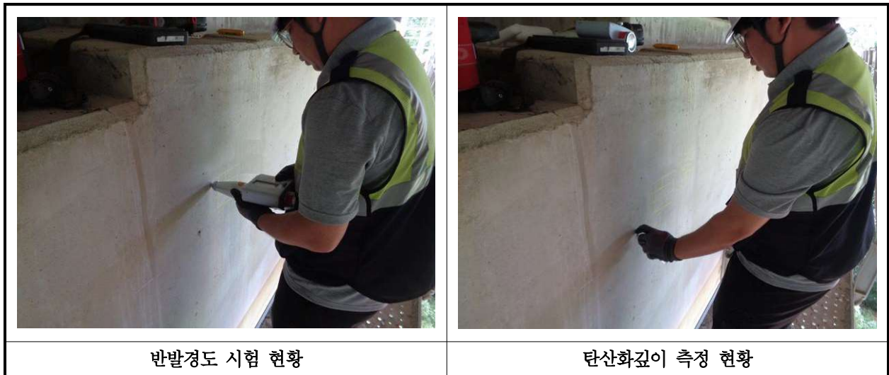
【사진 32.4.1】 콘크리트 내구성조사 현황
