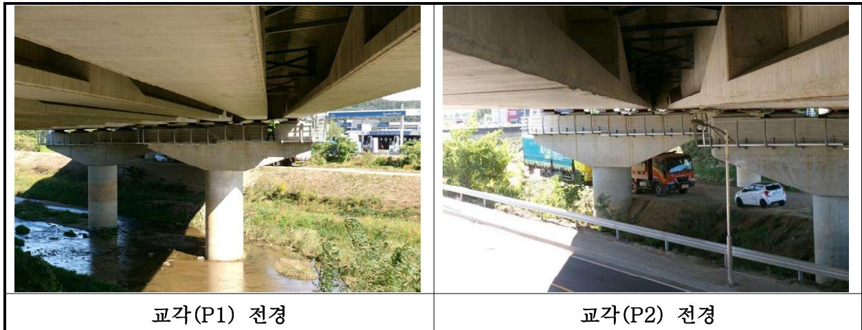
【사진 32.3.10】 교각 전경
