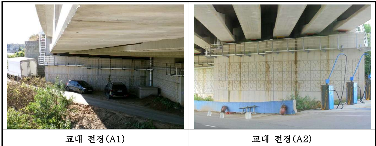
【사진 32.3.8】 교대 전경
